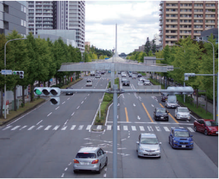
片側 3 ～ 4 車線の 50m 道路
