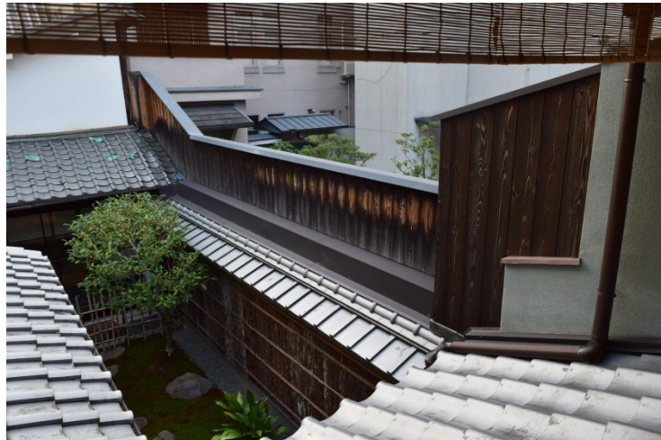
2階6畳間から防火塀（モルタル塀）
