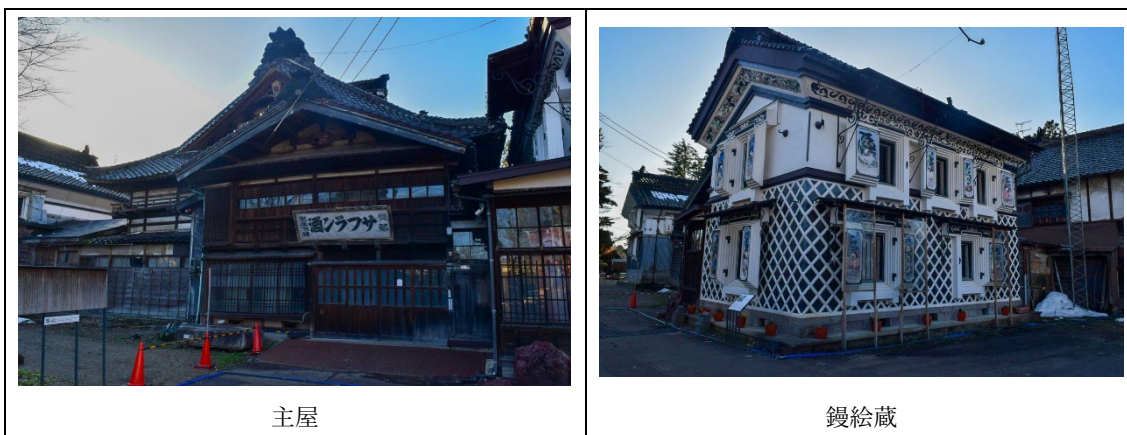
旧機那サフラン酒製造本舗施設群写真
