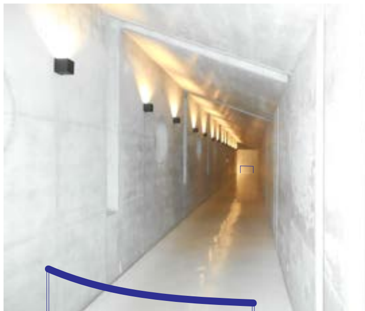
fig.7-3 進入禁止のボール
