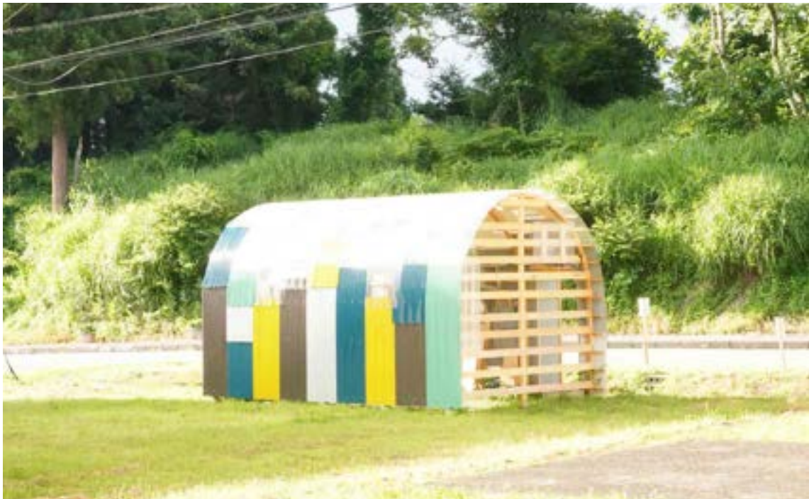
fig. 5-1 建設されたカマボコ型の展示施設
