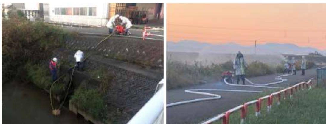
写真 21 消防団員が旧黒川からポンプを用いて取水・放水する様子
