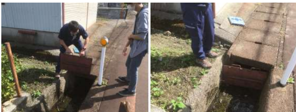
写真 16 せき板を溝に差し込む様子
