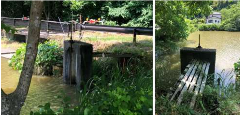
写真 24 堤下 ため池水門
