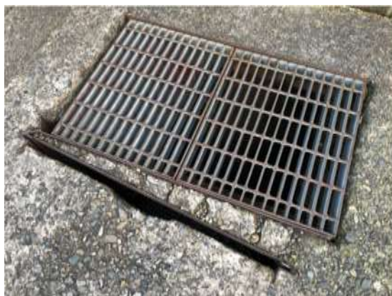
写真4 せき板を差し込むための溝
