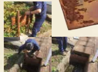
せき板を差し込む実際の様子
